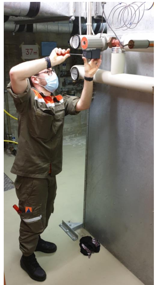
Abbildung 1: Ausführung von Wartungsarbeiten gemäss UCL
