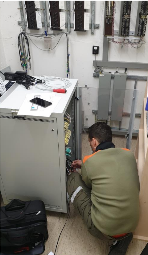
Abbildung 2: Wartungsarbeiten an der Telefonanlage
